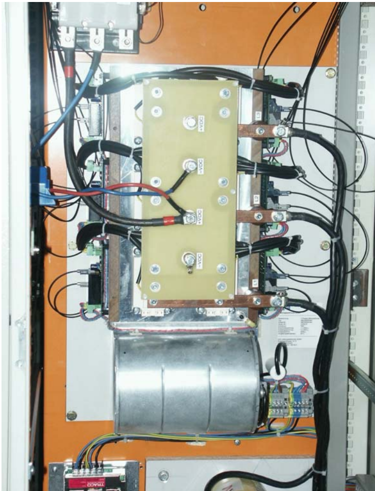
Bild 2: Ausgeführter Blindleistungsumrichter Zu sehen ist das Leistungsteil mit IGBT-Halbleitern, Anschlüssen für die drei Banddrosseln (rechts) und für den DC-Zwischenkreis (oben)
